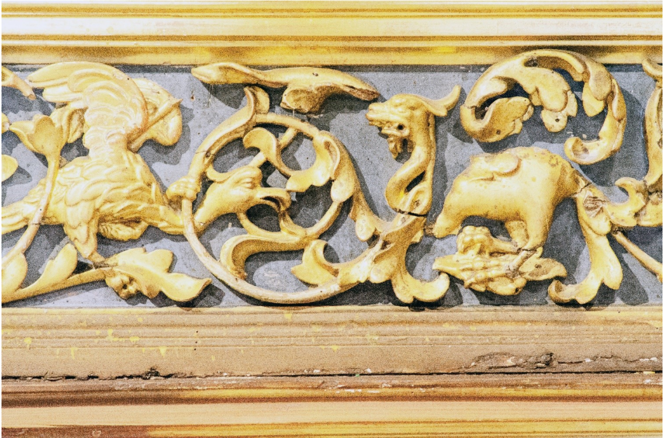
Dettaglio grottesche con evidenza di deterioramenti
